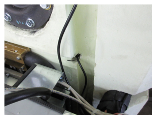
Sonda accumulo ACS in basso B41
