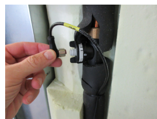
Misuratore di portata riscaldamento B2
