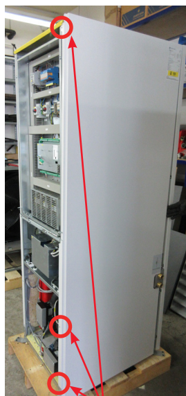
Svitare le viti di fissaggio
