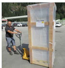
Trasporto di unità interna e esterna con carrello elevatore (transpallet)
