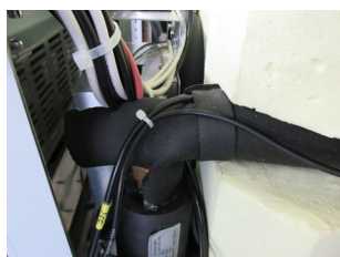
Sonda di mandata della pompa di calore B33
