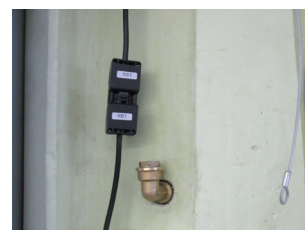
Connettore per la valvola di commutazione
