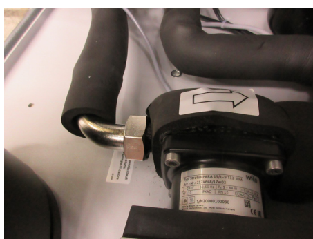
Allacciamento del ritorno della pompa di calore
