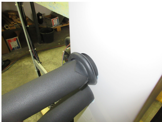
Tubi di collegamento flessibili isolati
