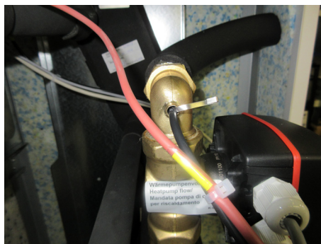
Allacciamento della mandata della pompa di calore
