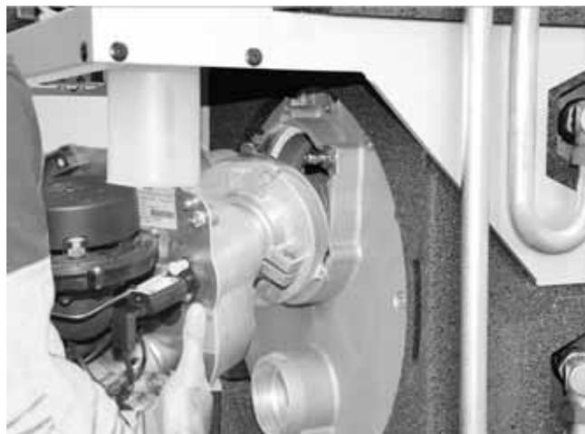
Fig. 64: Montaggio del bruciatore
