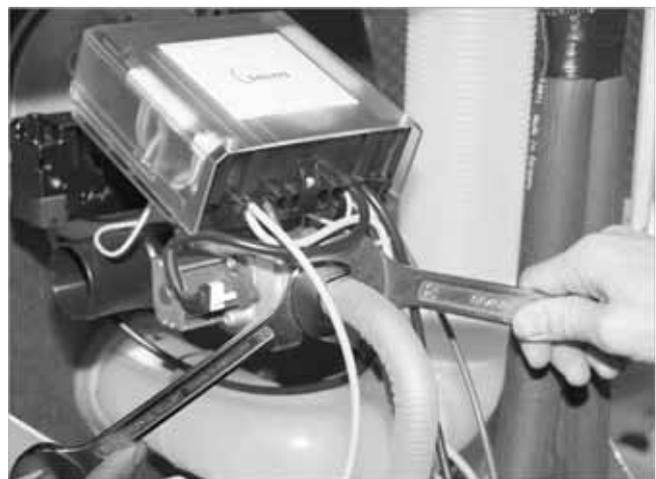
Fig. 54: collegamento della condotta del gas
