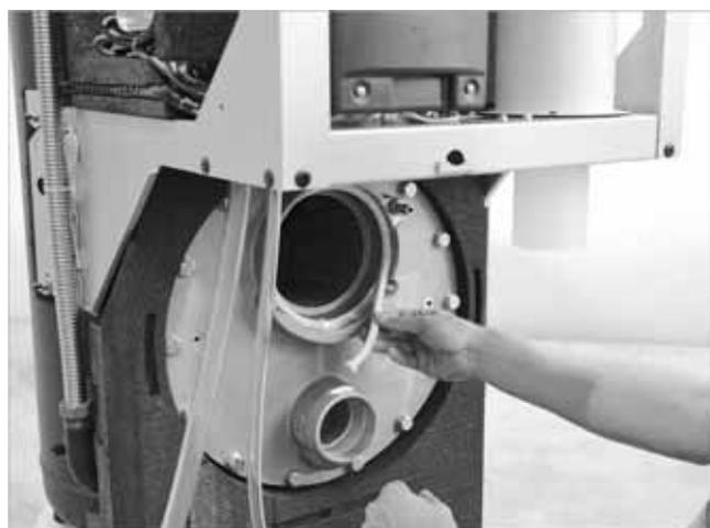
Fig. 40: Inserimento del cordoncino di tenuta del bruciatore
