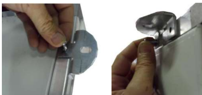
Figura 1 - Fissaggio delle staffe fornite a corredo
