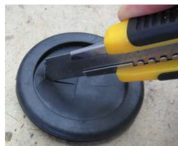
Incidere i gommini di protezione e tenuta
