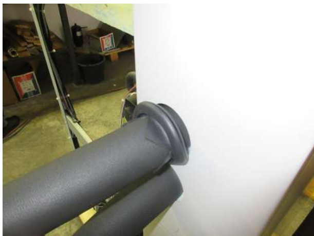
Tubi flessibili di collegamento con isolamento applicato
