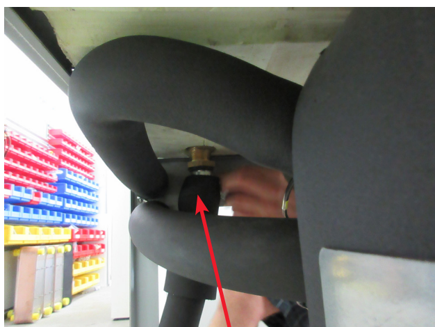
Isolamento Armaflex
