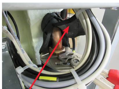
Isolamento Armaflex
