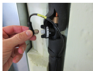
Misuratore di portata riscaldamento B2
