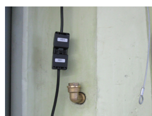
Connettore per la valvola di commutazione
