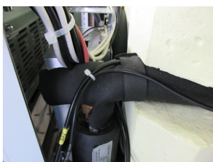
Sonda di mandata della pompa di calore B33
