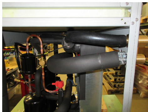
Vista frontale allacciamento Sole a sinistra con il tubo ingresso Sole accorciato
