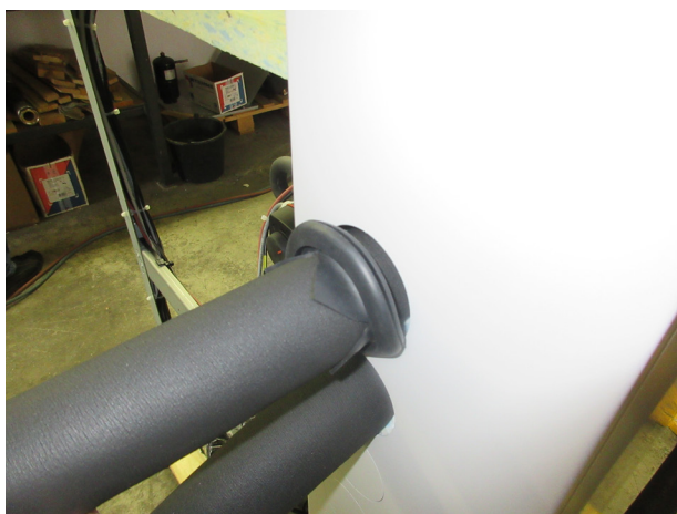
Flessibili di collegamento con isolamento premontato
